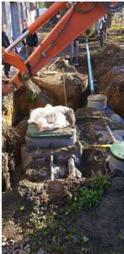
L'ancrage sans béton pour les filières Ecoflo PE2 5 et 6 EH est une **alternative à la réalisation d'une dalle d'ancrage en béton** pour les poses en conditions humides
