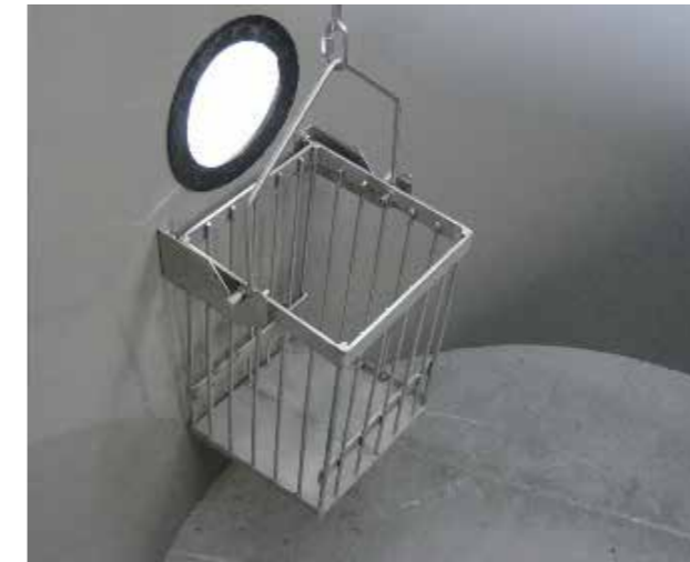
Panier de dégrillage
