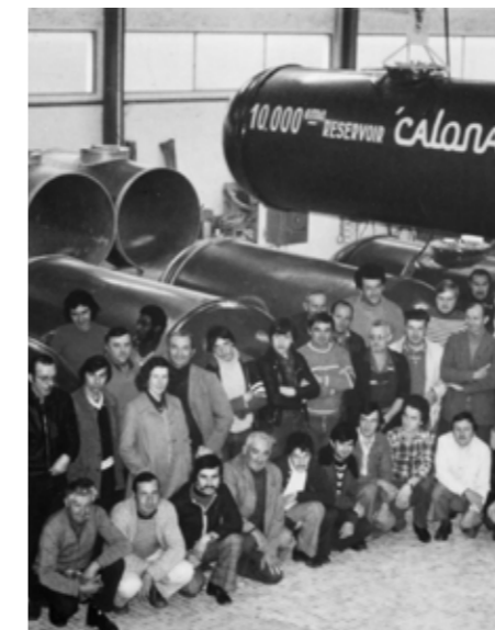
Atelier Premier Tech en 1979 (anciennement CMMC) à Chalennes-Sur-Loire (49)
