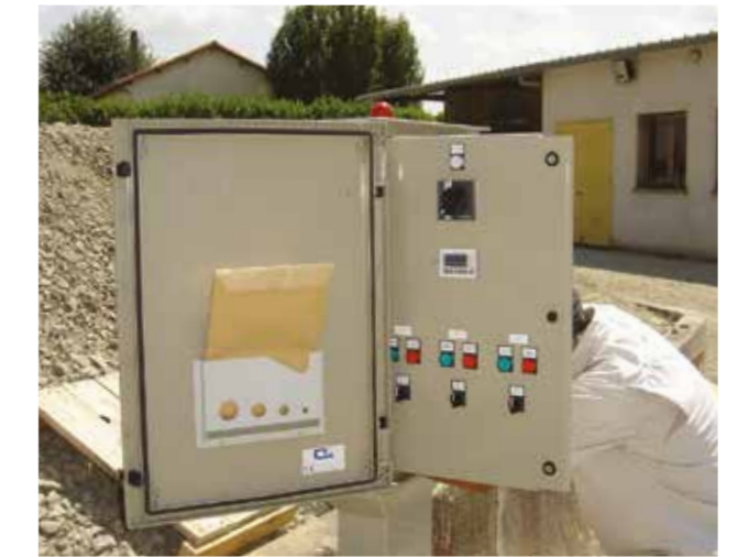
Armoire électrique (de type extérieur avec socle) Commande / protection. En option selon cahier des charges
