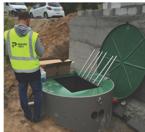
As estações elevatórias, ou poços, são usados para regular o caudal de águas residuais no sistema e fornecer pressão extra quando o movimento natural por gravidade não é possível. Por exemplo, ao ligar águas residuais de um edifício à rede municipal ou ao bombear águas residuais de uma ETAR para a área de descarga.
