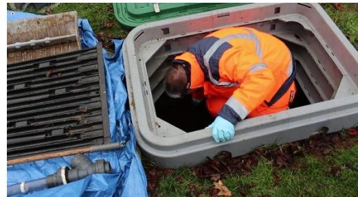
Enquanto os componentes internos estão a ser removidos, devem continuar a ser lavados para remover o máximo possível da biomassa que ainda possa ser aderida a eles. Esta operação deve ser sempre realizada em cima do acesso ao biofiltro para evitar a contaminação da envolvente da instalação.
