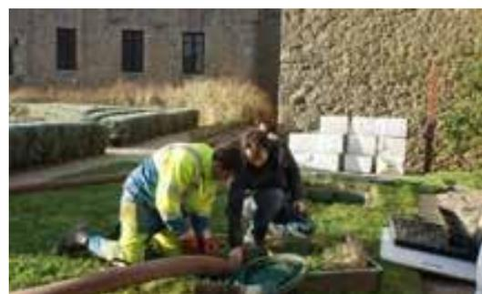
flotantes) y de la capa inferior (o lodos). Si superan el 50% de la altura de la fosa, debería procederse a su vaciado.
